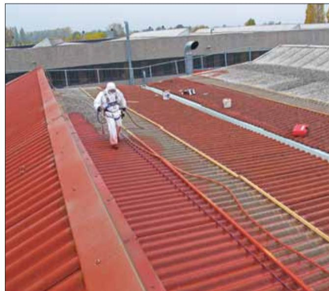
Il trattamento delle lastre in cemento-amianto con incapsulante colorato da parte di personale specializzato e operante in sicurezza
