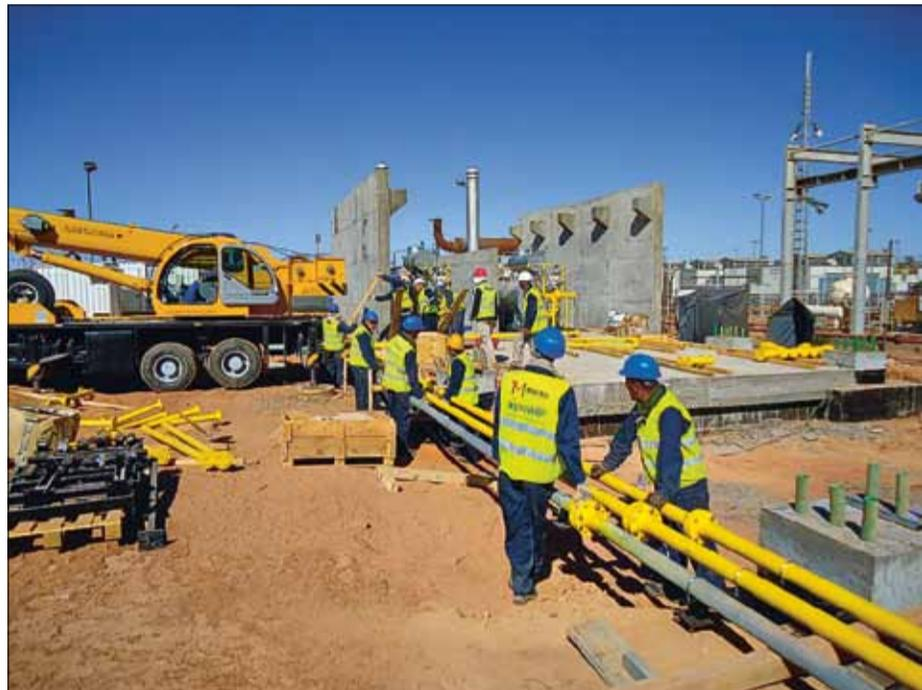
■ Una fase dei montaggi meccanici della nuova centrale elettrica di Illizi, dove CPL ha fornito il "poste de gaz"
