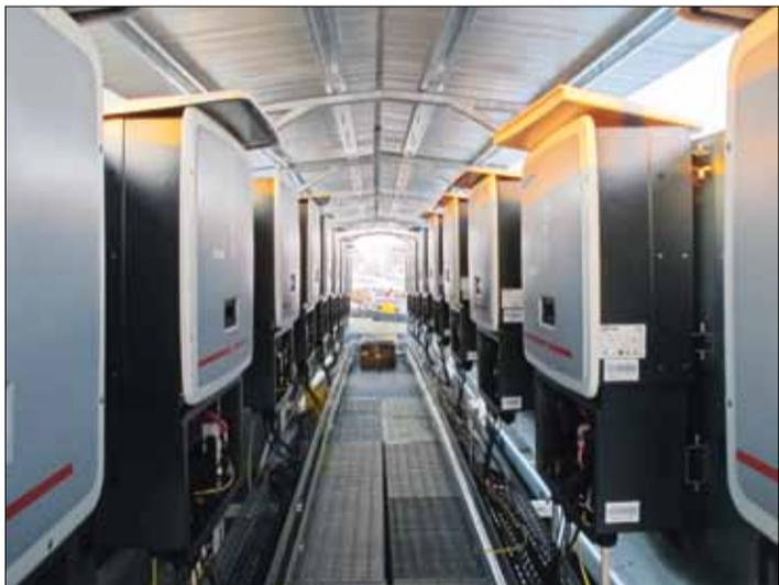
■ Gruppo di inverter posizionati in copertura in apposita struttura: ai pannelli sono stati accoppiati 47 inverter da 20KW, per garantire la massima modularità dell'impianto
