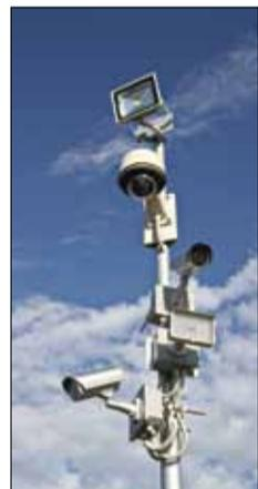
■ Un particolare dell'impianto di videosorveglianza e anti-intrusione posto a protezione dei pannelli
