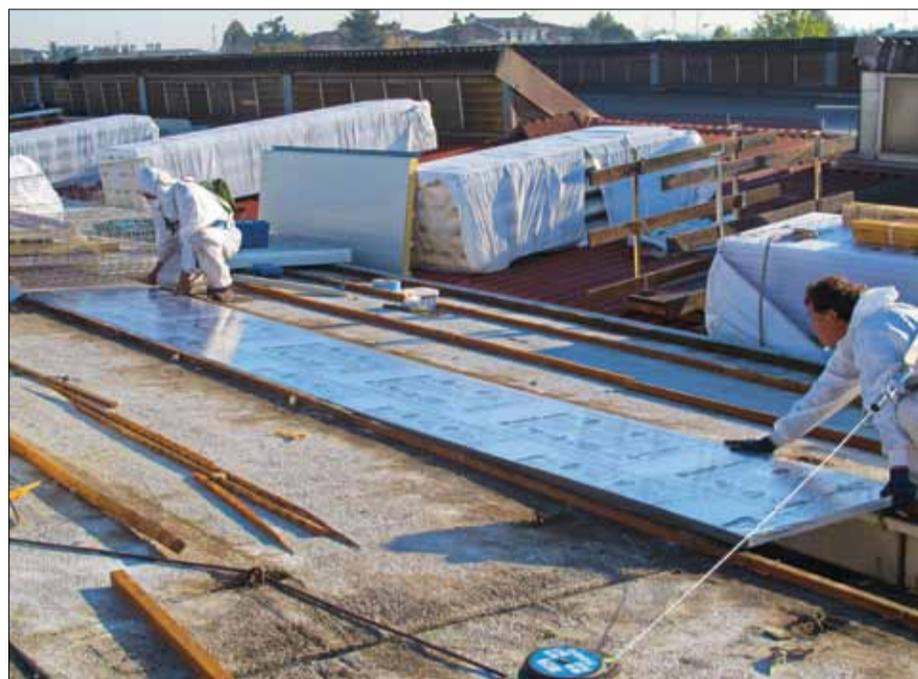
Il posizionamento delle nuove lastre in polycarbonato alveolare: la contemporaneità delle operazioni in copertura e delle attività dello stabilimento sono state gestite mediante un piano di microinterruzioni della produzione
